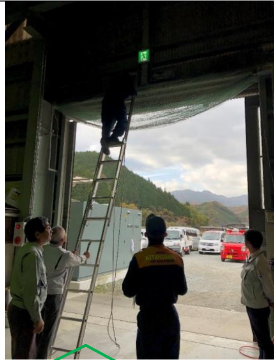
11 月 29 日：誘導灯検査の様子
